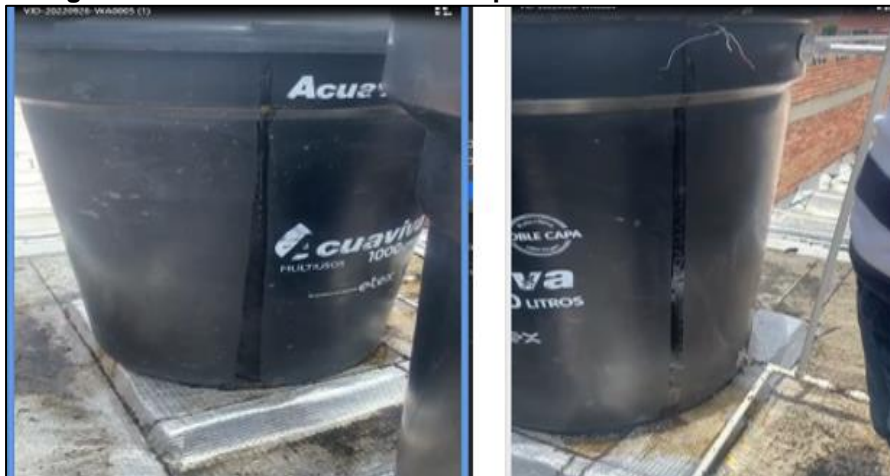
Imagen 115. NP-3 Mantenimiento tanque elevado de 250 lts a 1000 lts
