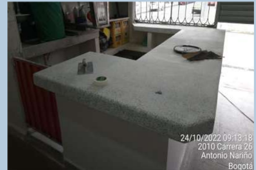
Instalación de mesón en granito pulido P.C. 4 Vientos
