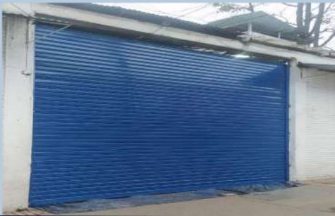
Instalación de puerta en P.C. Plaza España
