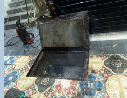
Mantenimiento trampa de grasas PDM La Concordia
