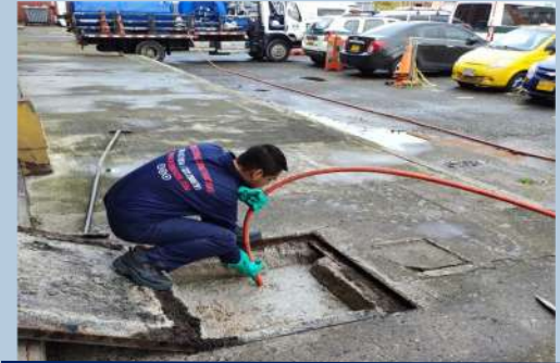
Mantenimiento cajas de inspección San Andresito 38
