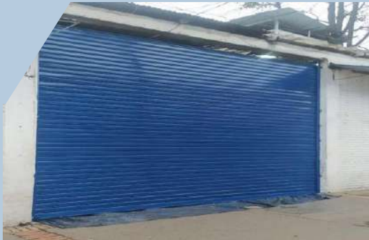
Instalación de puerta en P.C. Plaza España
