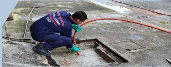
Mantenimiento cajas de inspección San Andresito 38
