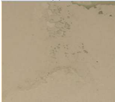
Foto No. 2: Estuco y pintura cocina No. 12
