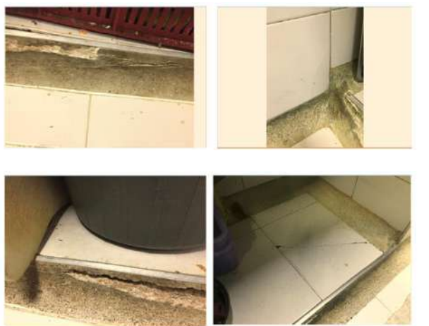
Foto No. 1: Estado de las cocinas
