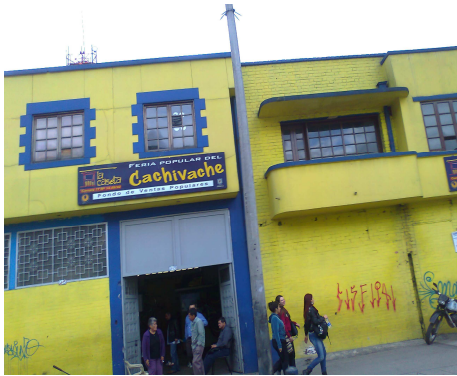
Fachada principal en mal estado infraestructura
