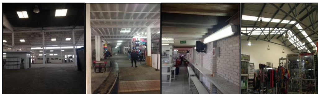
Figura 10. Sistema de Iluminación en Puntos Comerciales
